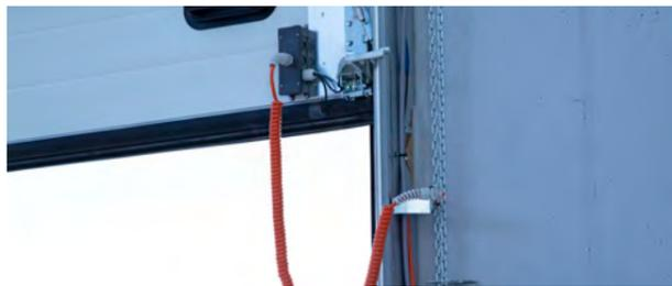
Sicherheitsvorrichtung bei Kabel- und Federbruch
