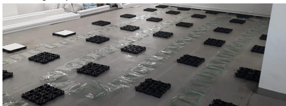
Zwischen den Plattenreihen kann eine thermostatische Heizmatte installiert werden, die von einer Schalttafel gesteuert wird und eine konstante Temperatur unter den Bodenplatten gewährleistet, um zu verhindern, dass die Tau-Temperatur erreicht wird.
