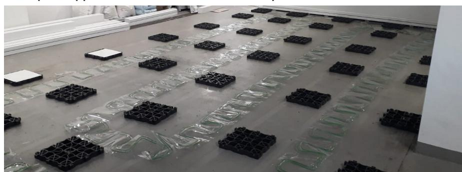
Entre les rangées de plaques, il est possible d'installer un tapis chauffant contrôlé par un panneau électrique, qui assure une température constante sous les panneaux du sol, de manière à empêcher le point de rosée d'être atteint.
