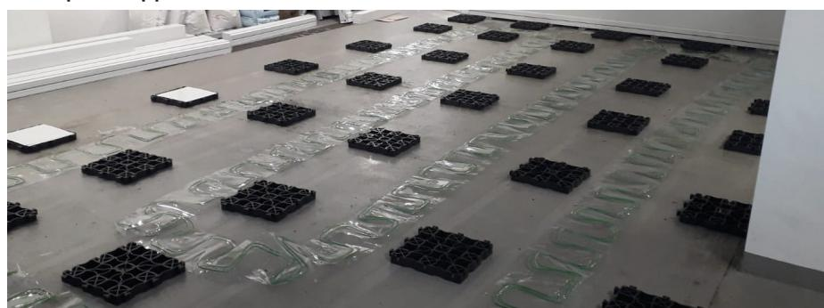
Tra le file di piastre è possibile installare una stuoia riscaldante termostata controllata da quadro elettrico, che assicura costante temperatura al di sotto dei pannelli di pavimento, in modo da impedire il raggiungimento della temperatura di rugiada.
