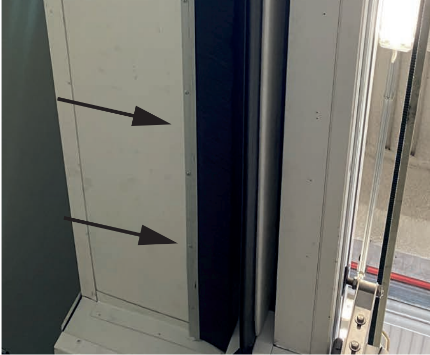
Bürstendetail im Kurbelgehäuse
