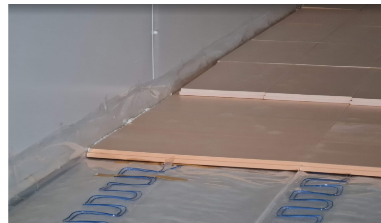
Stuoia riscaldante su cella a temperatura negativa.
