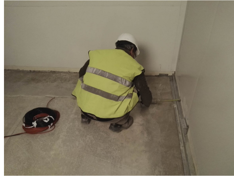
Tracciare a terra le partenze della prima striscia.
