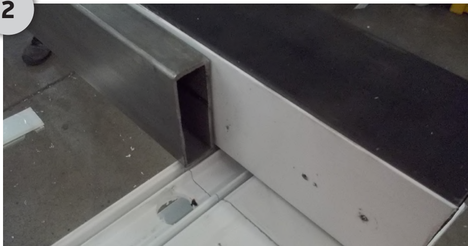
I due terminali della soglia non devono essere fissati lateralmente alla soglia
