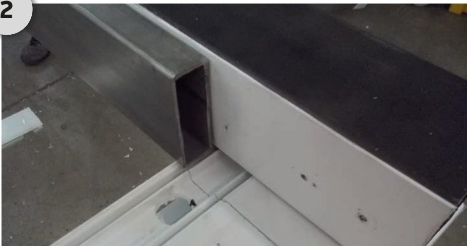
Les deux extrémités du seuil ne doivent pas être fixées latéralement
