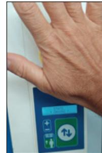
Auf dem Display des LCD-Bedienteils erscheint die Anzeige "NOT-AUS-STATUS TASTE" und das Tor ist und bleibt in allen Funktionen gesperrt. Für die Freigabe des Pilzes muss eine Teilrotation des roten Pilzes durchgeführt werden. Nach einigen Sekunden erlischt die Anzeige "NOT- AUS-STATUS TASTE" auf dem Display, und die Tür kehrt in den Betrieb zurück, während sie auf einen Befehl wartet.
